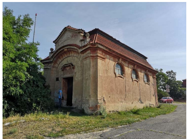
Stav objektu před rekonstrukcí
