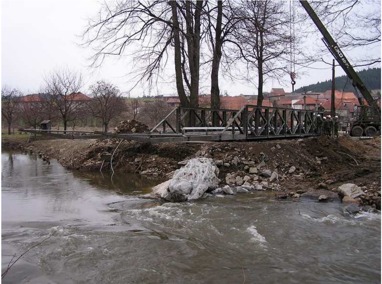
Obr. 6. Vlastní realizace stavby MS v Číchově
